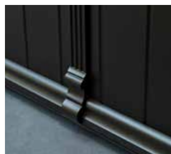
Un rejet d'eau horizontal en bas, une pièce d'ornement au milieu.
